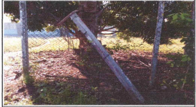
fotos 2: se observa la circulación de la escuela en mal estado
